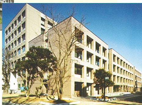
改修後 1号館 16.2撮影
